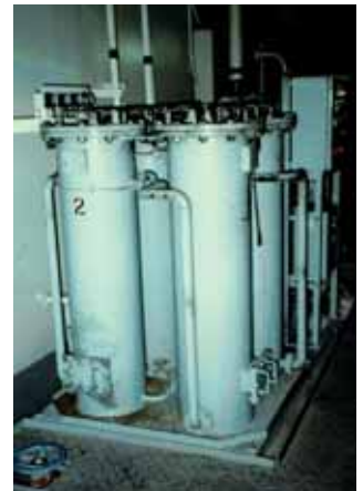
排水処理量：2 m 3 / h PCC-6A 充填：80 kg (20 kg × 4塔) LV = 28.5 m / h SV = 35
