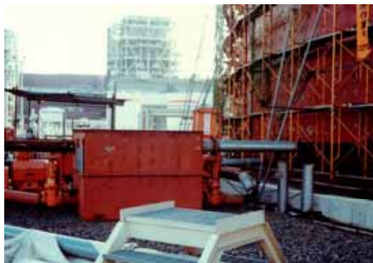
タンク水張り試験排水処理
