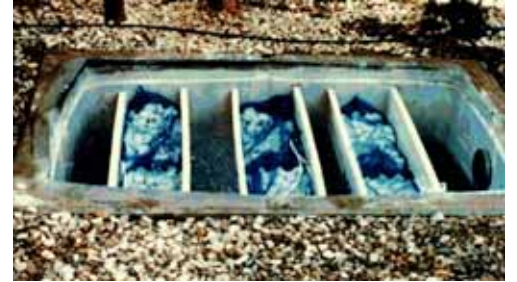
除外設備排水処理
